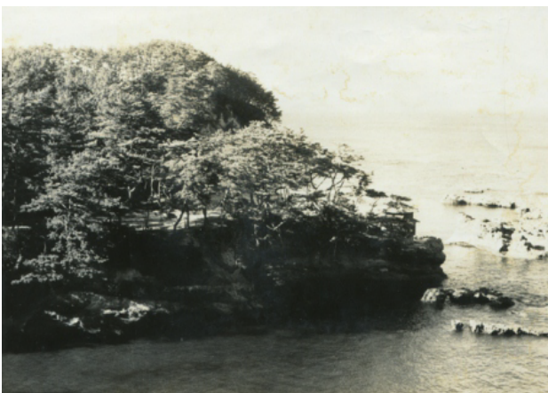
南側対岸から見た六角堂(昭和38年以前) 六角堂向かいの岩礁に生える松の本数が少なくなっている。
